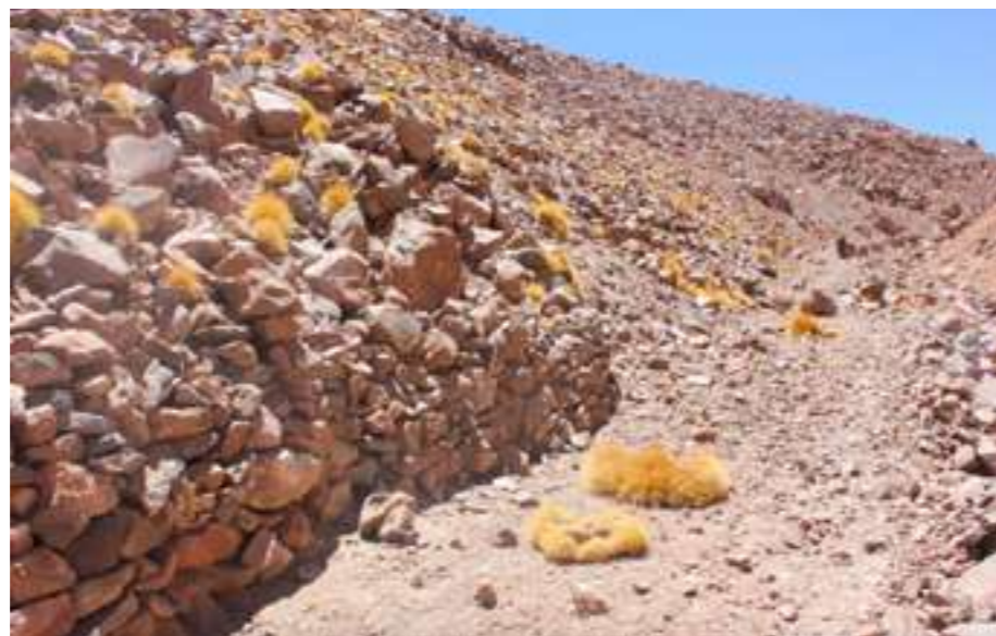
Detalle de camino tropero con gavión de contención, Quebrada del Inca.
