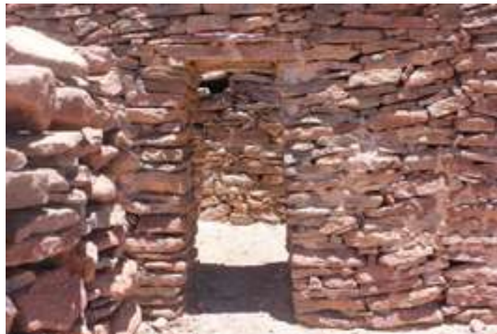
Rasgo constructivo típicamente inca, sus dinteles es una característica arquitectónica única en esta cultura.
